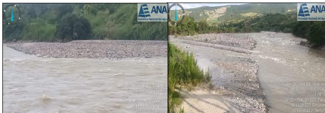
Imagen2.- Se observa colmatación del cauce , vulnerable ante el riesgo de inundación
